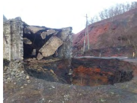
Рис. 1. Провалля, яке утворилось біля устя свердловин аварійної шахти № 29, пов'язаної виробками із шахтою «Лісова» Донецької області (припинила видобуток в 2002 р.)
