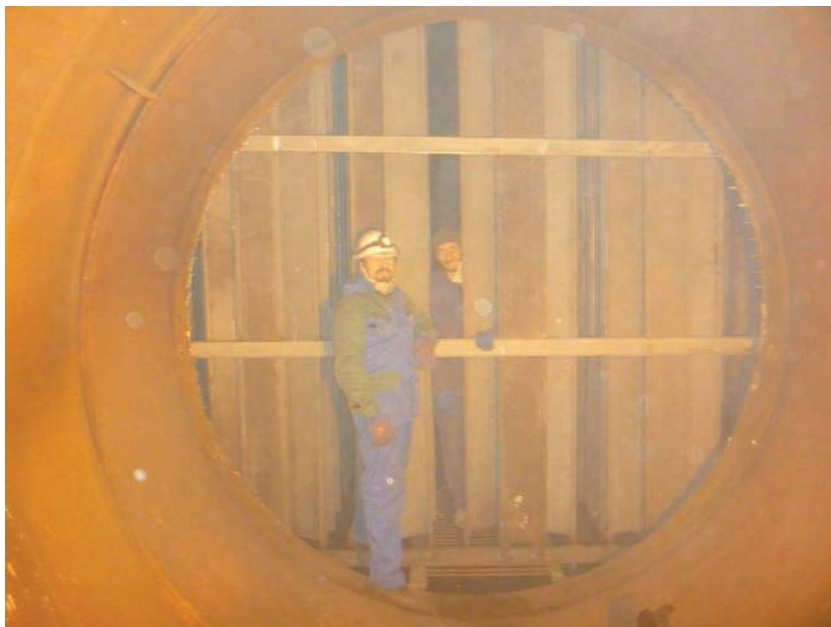
Рис. 2. Аппарат инерционного осаждения «VAV-250-АФК». Газовый коллектор агломашины № 12 ПАО «ДМК». Декабрь 2015 года
