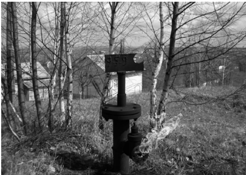
Рис. 7. Витоки вибухонебезпечних газів з ліквідованої свердловини № 959, вул. Городище м. Борислав
